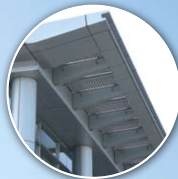
本港有不少太陽能光伏的應用，科學園的建築物附有光伏系統
