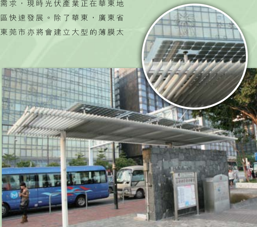
位於尖沙咀海濱花園安裝了一套附設於建築物的光伏系統
