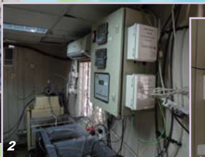
1. 從網絡攝影機的實景照片，昂船洲小型污水處理廠設置了「廢水管理資訊系統」，進行監測試驗。 2.&3. 數據採集器和數據處理發射器。
