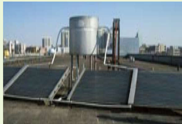
太陽能熱水器 Solar Water Heater
